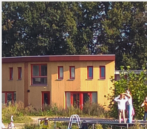
De huizen van Ecodorp Boekel zijn klimaatpositief gebouwd. In deze woningen zit 800 ton CO2 opgeslagen.
